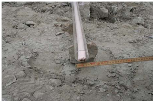
Figur 5: Laddsträng efter gasning
