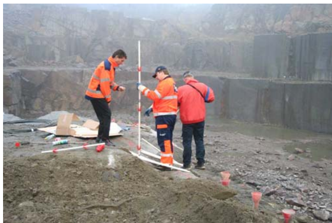
Figur 34: Laddning av emulsionsrör
