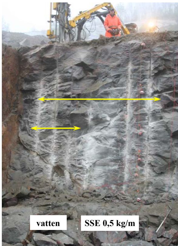
Figur 37: Pipor efter hål 17-23, simulerad Nonel-upptändning
