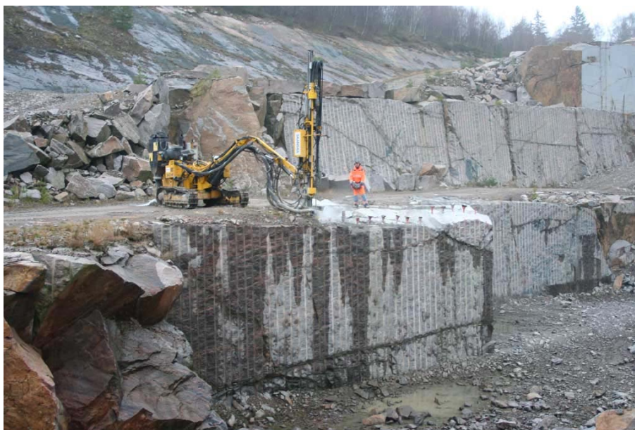
Figur 31: Borrning av hålen i etapp 3
